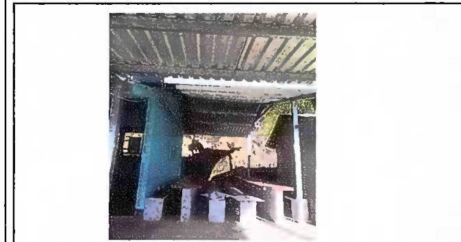
Foto 1: Área del comedor. Sustitución de lámina por lámina troquelada aluzinc calibre 26 (área del comedor) y Sustitución de estructura de soporte de madera, por metal
