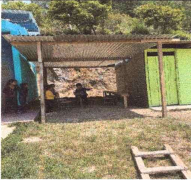
Foto 1: Área del comedor. Sustitución de lámina por lámina troquelada aluzinc calibre 26 (área del comedor) y Sustitución de estructura de soporte de madera, por metal
