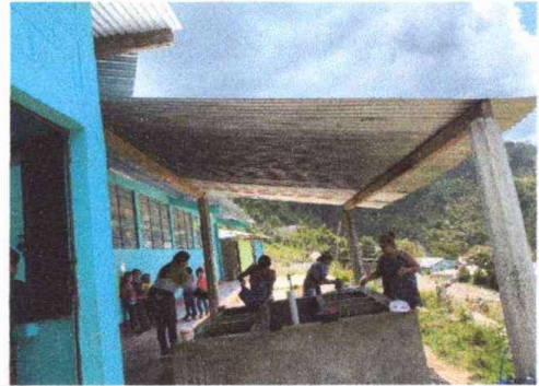
Foto No. 2: Área recreativa. Sustitución de lámina por lámina troquelada aluzinc calibre 26
