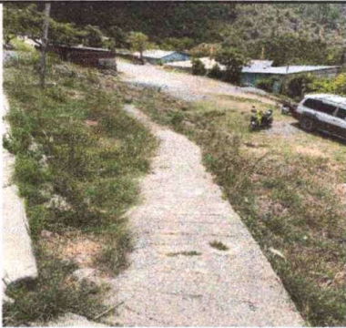
Foto No. 3: Patio. Sustitución de estructura de soporte de madera, por metal
