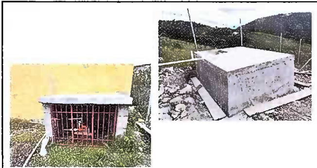
Foto 2: Reparación de cisterna de concreto y sustitución de bomba de agua.
