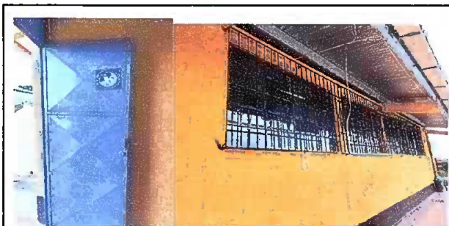
Foto 4: Modulo II: Mantenimiento de estructura de puertas de aula (lijado y pintado) suministro e instalación de balcones a aulas.
