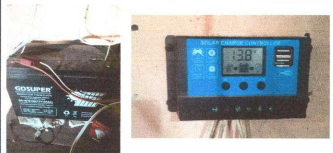
Foto No. 10. Modulo II. Sustitución Bateria de 200 amp y regulador de 60 amp.
