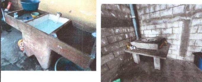
Foto No. 7. Modulo III: Sustitucion de pila de cemento de un lavadero INSITU (1.20mts de largo por 1 metro de ancho). Instalacion de azulejo a estufa rural
