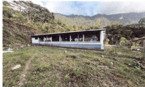
Foto 2: VISTA DEL MODULO AL INGRESO DE LA VISITA..
