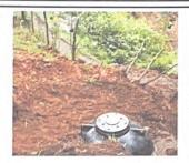
Foto 9: TRABAJO DE INSTALACION DE FOSA SEPTICA Y TUBERIA DE AGUA Y DRENAJE PARA SANITARIOS
