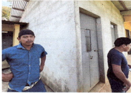
Foto 2: AREAS DEL MODULO, SIN PINTURA.
