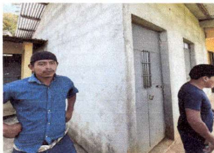
Foto 2: ÁREAS DEL MODULO, SIN PINTURA.
