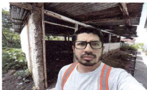
Foto 11: FOTO CON MODULO DE AULA ABANDONADO DE FONDO, AL FINAZLIZAR LA VISITA.
