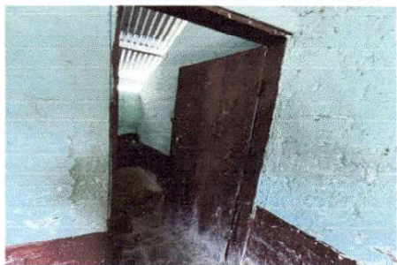
Foto 5: PUERTAS DE MADERA DEL MODULO, CAIDAS Y PODRIDAS.
