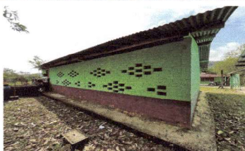
Foto 2: VISTA GENERAL DEL MODULO A REMOZAR.
