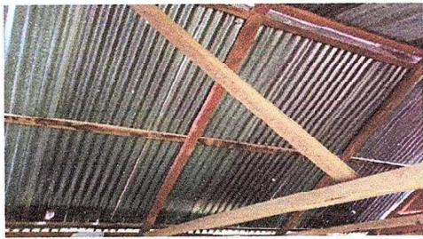
Foto 9, Cocina: Sustitución de lámina por lámina troquelada aluzinc calibre 26
