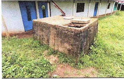
Foto 7, Depósito de Agua: Sustitución de tanque de concreto por depósito de agua
