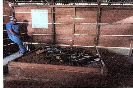
Foto 10, Cocina: Sustitución de estufa rural (completa) incluye chimenea y plancha de metal
