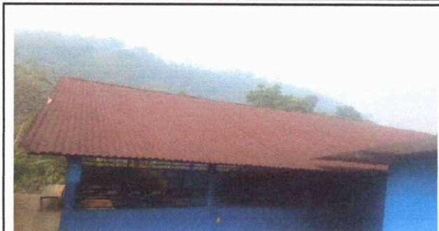
Foto No.1: Módulo I: Sustitución de lámina por lamina troquelada calibrí 26
