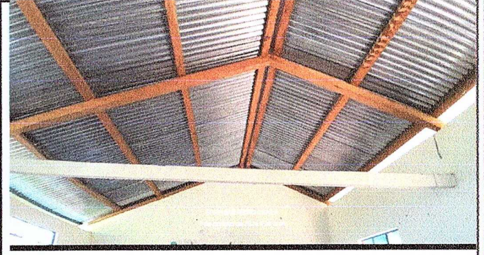
Foto 2. Modulo1 Sustitución de estructura de soporte de madera por metal
