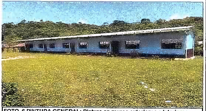
FOTO. 6 PINTURA GENERAL: Pintura en muros exteriores e interiores
