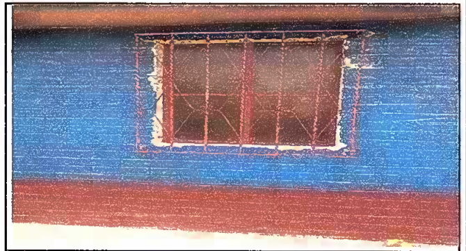
FOTO.2 Modulo I : Sustitución de ventanas de madera por metal mas vidrio
