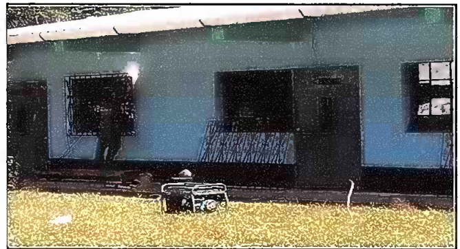
FOTO. 4 Modulo II: Suministro e Instalacion de balcones
