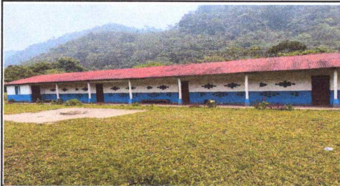
FOTO. 1 Modulo I: Sustitucion de puertas
