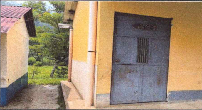
FOTO. 3 Modulo II: Suministro e instalacion de chapas
