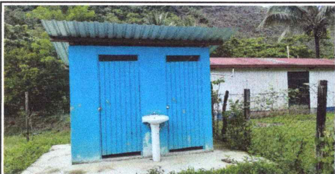
FOTO. 5 MODULO III Sustitucion de puertas de servicio sanitario
