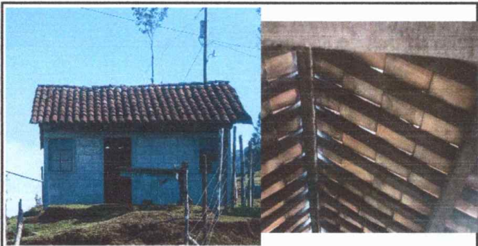
Foto No.5: MODULO II. Sustitución de techo de cocina escolar por estructura metálica y lamina troquelada calibre 26.
