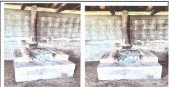
Foto No.6: MODULO II. Instalación de azulejo y sustitución de plancha y chimenea en estufa rural.
