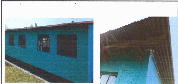
Foto No. 1: MODULO I. Sustitución de laminas en mal estado por lámina troquelada alucinc roja calibre 26.
