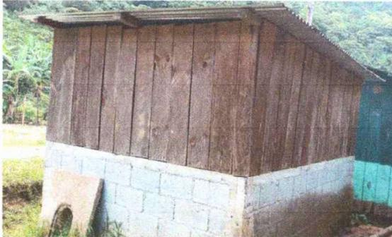
Foto No. 1: COCINA. Sustitución de paredes de madera por block.
