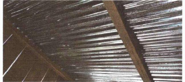
Foto No. 2: COCINA. Sustitución de lámina por lámina troquelada.
