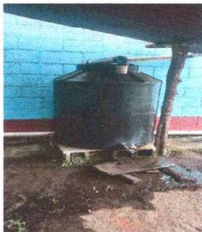
Foto No. 5: PATIO. Sustitución de depósito de agua 1700 lt.
