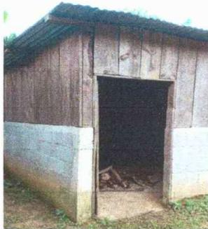
Foto No. 3: COCINA. Sustitución de estructura de soporte de madera por metal.
