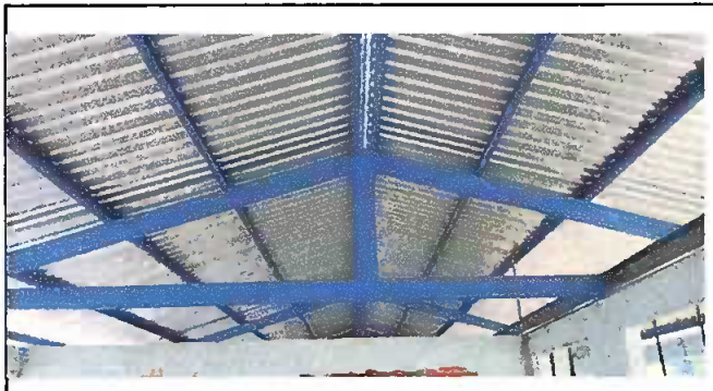
costaneras colocadas dentro de las aulas
