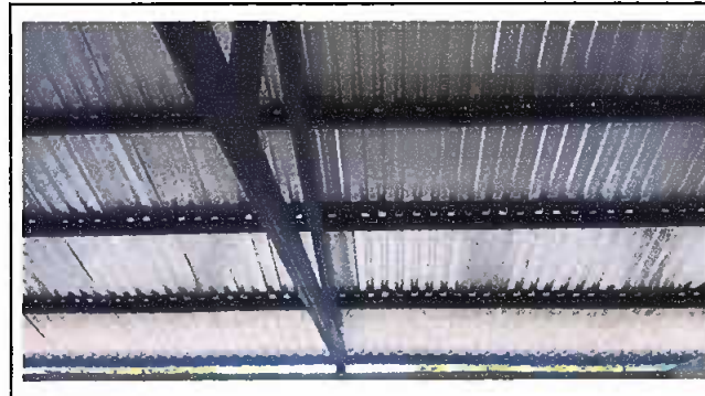
costaneras de metal colocadas
