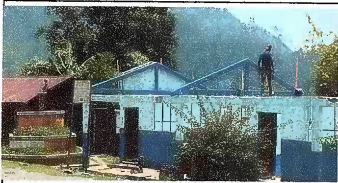
Foto 3: Aula No. 3 colocacion de tijeras metalicas
