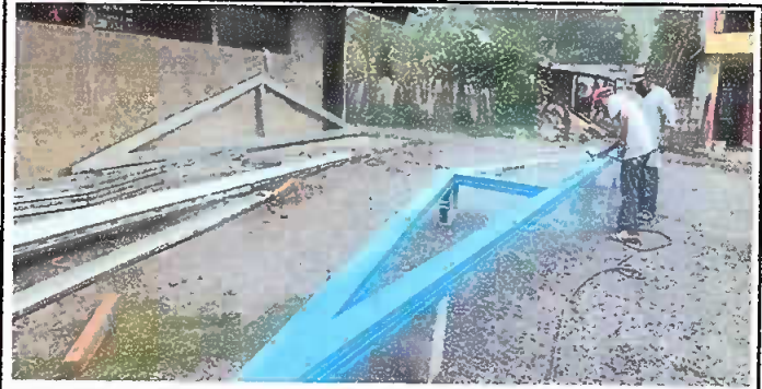
Foto 2: Aula No.2 pintado de estructuras metalicas
