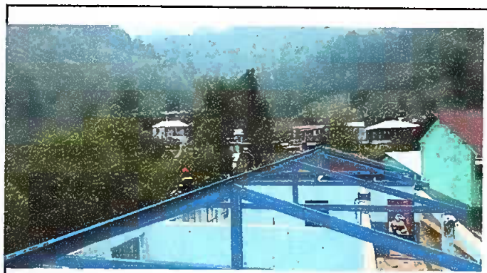
Foto 4: Aula No. 4 colocacion de estructura metalicas
