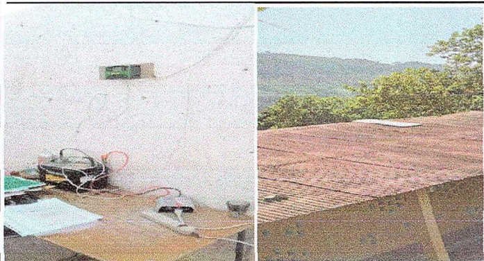
Foto 5: Modulo 2. Sustrucción de panel solar
