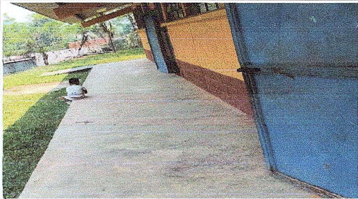
Foto 1: Modulo 1. Sustrucción de piso de torta concreto por piso de granito
