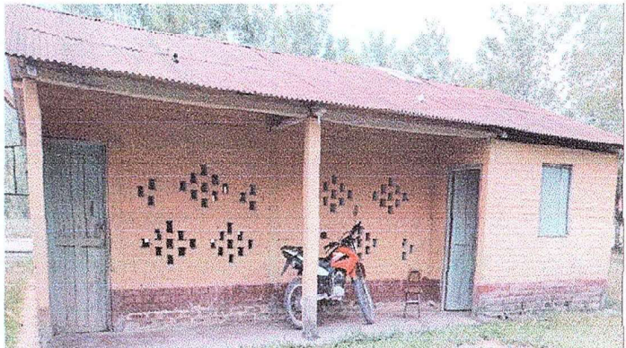
Foto 4: Modulo 2. Sustrucción de puertas y ventanas de madera por metal
