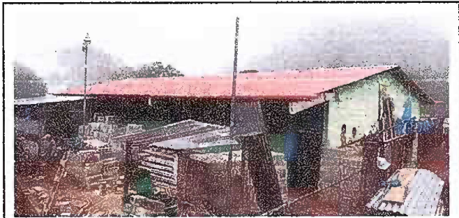
Foto 1: Modulo 1: sustitución de lamina por lamina troquelada y de canal en mal estado por tubo pvc.
