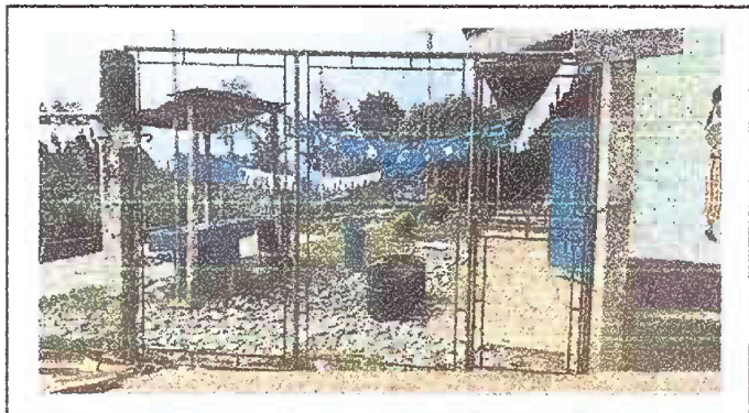
Foto 4: Sustitución de portón en mal estado.
