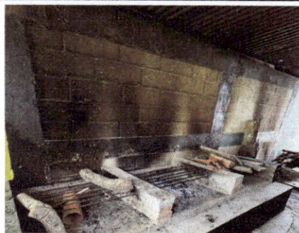
Foto 8: REPARACION Y AMPLIACION DE ESTUFA DE LEÑA.
