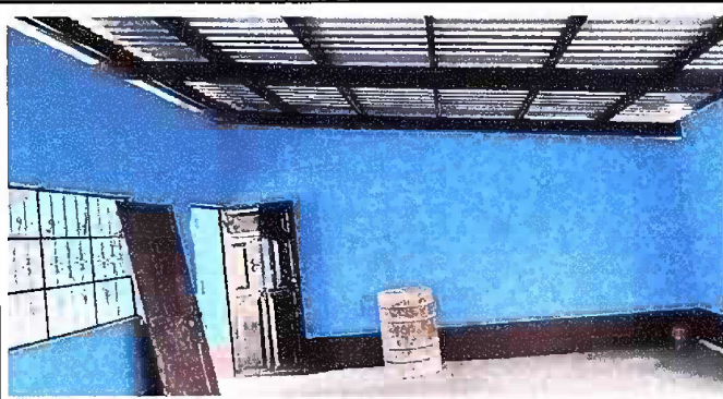
Foto 3: MODULO 1: MANTENIMIENTO A ESTRUCTURA DE SOPORTE
