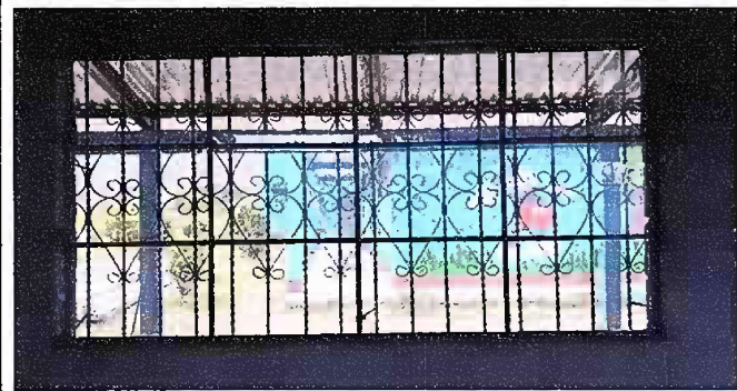
Foto 5: MODULO 1: SUSTITUCIÓN DE VIDRIOS
