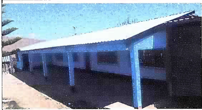
Foto1: MODULO 1: SUSTITUCION DE LÁMINA
