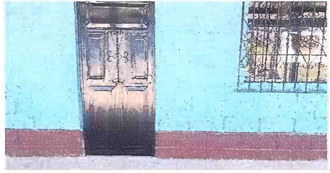
Foto 2: MODULO 1: SUSTITUCION DE PUERTAS
