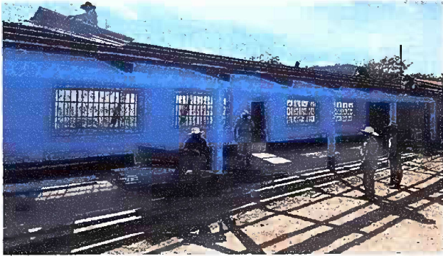
Foto1: MODULO 1: SUSTITUCION DE LÁMINA
