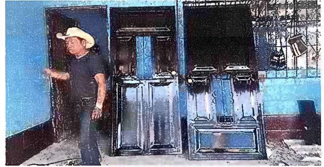
Foto 2: MODULO 1: SUSTITUCION DE PUERTAS
