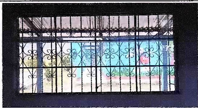
Foto 5: MODULO 1: SUSTITUCIÓN DE VIDRIOS
