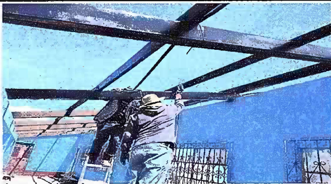
Foto 3: MODULO 1: MANTENIMIENTO A ESTRUCTURA DE SOPORTE
