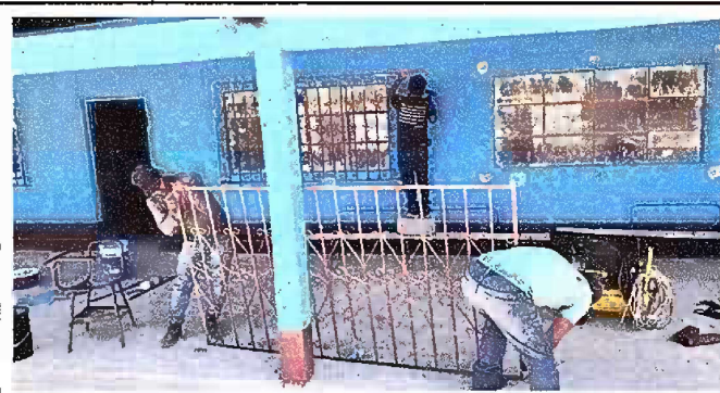
Foto 6: MODULO 2. SUSTITUCION DE BALCONES
