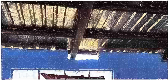
Foto 3: MODULO 1: MANTENIMIENTO A ESTRUCTURA DE SOPORTE
