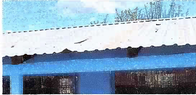
Foto1: MODULO 1: SUSTITUCION DE LÁMINA
