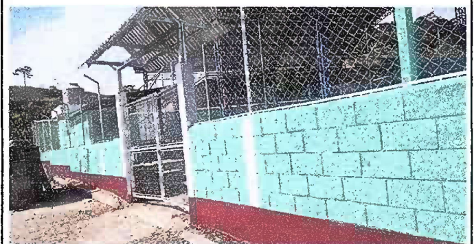
Foto 8, MURO PERIMETRAL, REPARACIÓN DE MALLA
