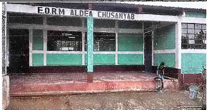
Foto 9: PINTURA GENERAL EN MUROS EXTERIORES E INTERIORES
