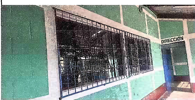
Foto 4: MODULO 1: SUSTITUCION DE BALCONES
