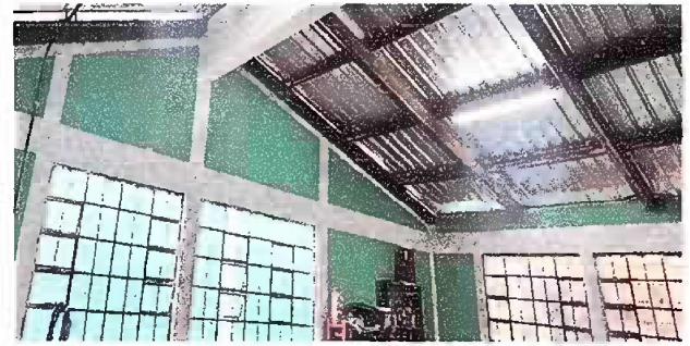
Foto 5: MODULO 1: SUSTITUCION DE VIDRIOS
