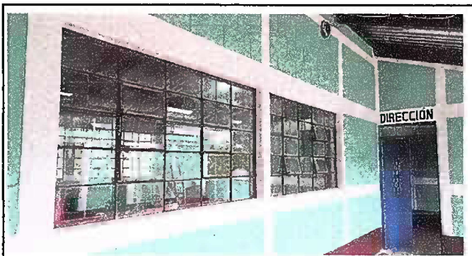
Foto 5: MODULO 1: SUSTITUCION DE VIDRIOS
