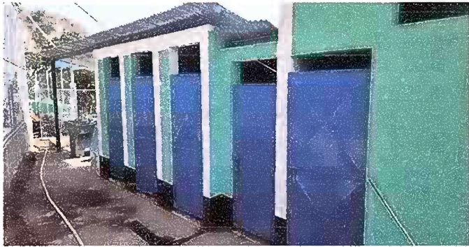
Foto 7: MODULO 3: MANTENIMIENTO DE PUERTAS
