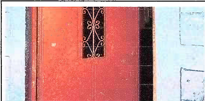
Foto 2: MODULO 1: MANTENIMIENTO DE PUERTAS Y SUSTITUCION DE CHAPA
