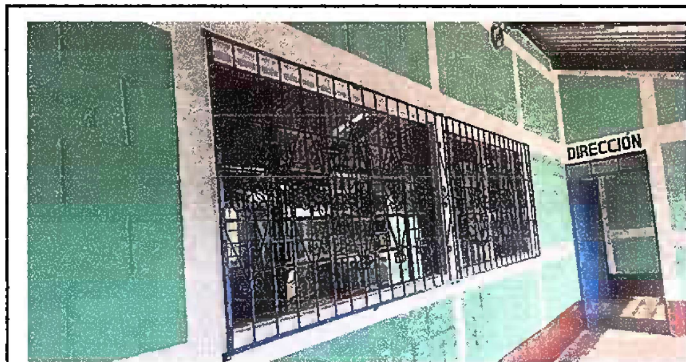
Foto 4: MODULO 1: SUSTITUCION DE BALCONES
