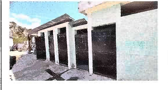
Foto 7: MODULO 3: MANTENIMIENTO DE PUERTAS
