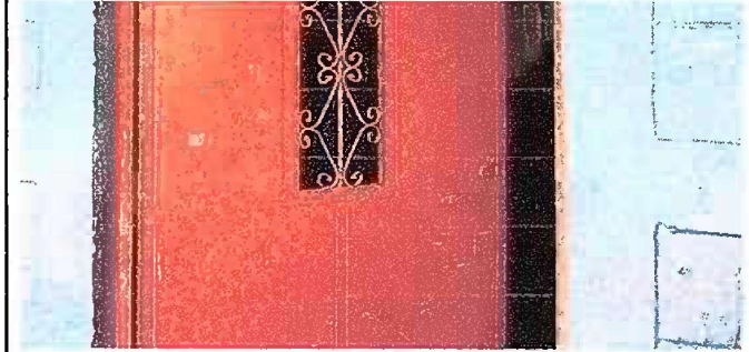
Foto 2: MODULO 1: MANTENIMIENTO DE PUERTAS Y SUSTITUCION DE CHAPA
