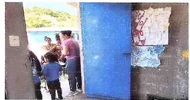
Foto 7: MODULO 2: MANTENIMIENTO DE PUERTAS
