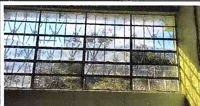
Foto 4: MODULO 1: SUSTITUCION DE VIDRIOS EN VENTANAS
