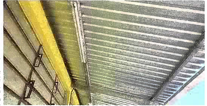
Foto 2: MODULO 1: CAMBIO DE ESTRUCTURA SOPORTANTE DE TECHO
