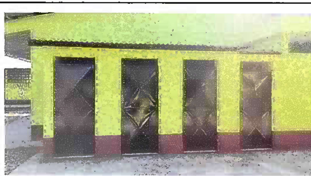
Foto 4: MODULO 3: MANTENIMIENTO A PUERTAS DE SANITARIOS
