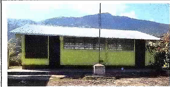
Foto1: MODULO 1: CAMBIO DE LAMINA
