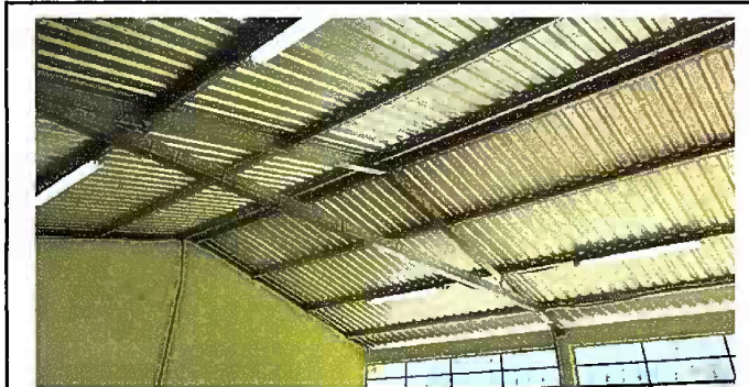
Foto 3: MODULO 1: SUSTITUCIÓN DE LAMPARAS E INSTALACION ELECTRICA
