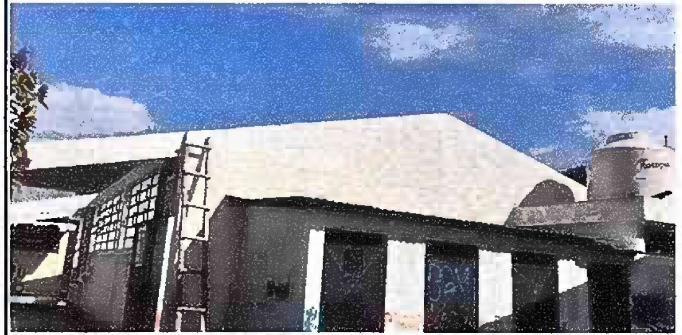
Foto 2: MODULO 1: CAMBIO DE ESTRUCTURA SOPORTANTE DE TECHO
