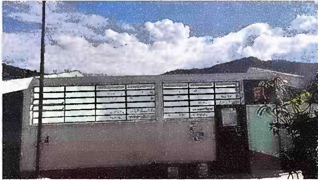
Foto 1: MODULO 1: CAMBIO DE LAMINA
