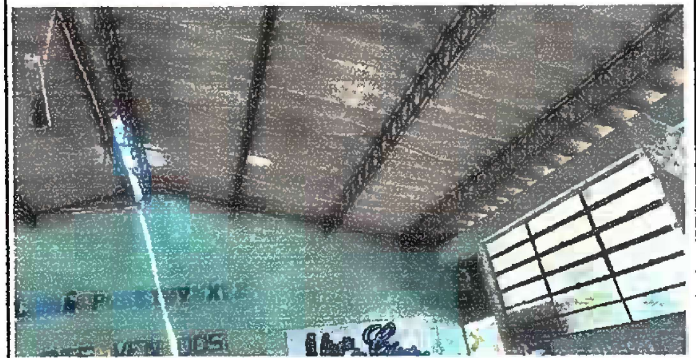
Foto 2: MODULO 1: CAMBIO DE ESTRUCTURA SOPORTANTE DE TECHO
