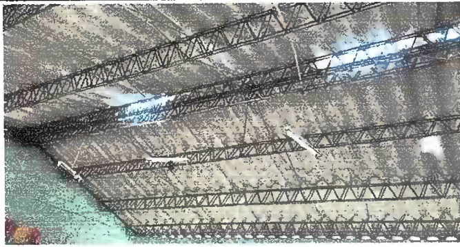
Foto1: MODULO 1: CAMBIO DE LAMINA
