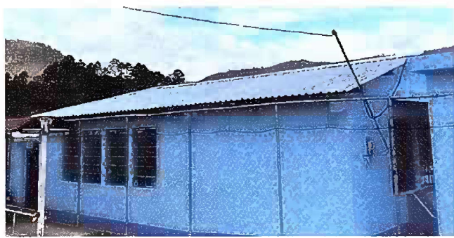
Foto1: MODULO 1: SUSTITUCION DE LÁMINA
