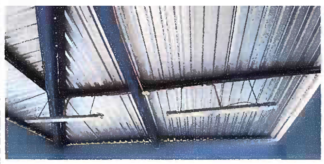
Foto 2: MODULO 1: SUSTITUCION DE LÁMPARAS
