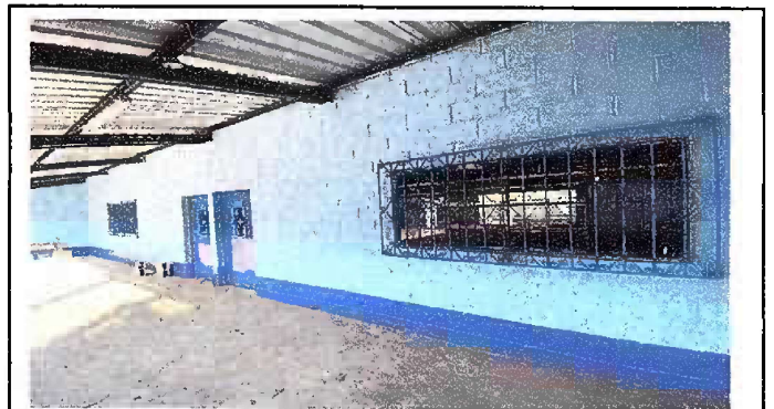
Foto 10: MODULO 2: MANTENIMIENTO DE BALCONES
