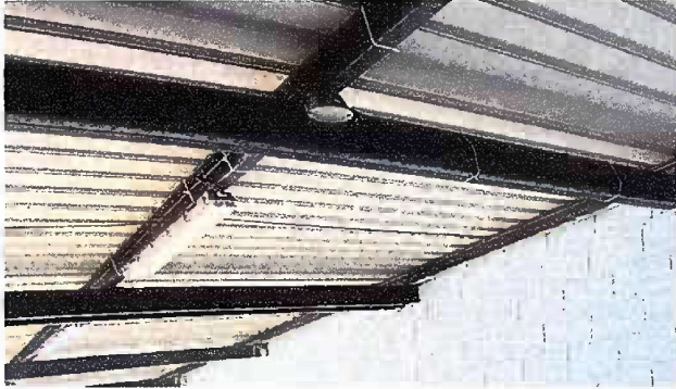
Foto 7: MODULO 2: SUSTITUCION DE LÁMPARAS
