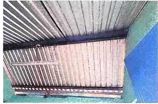
Foto 8: MODULO 2: REPARACION DE CABLEADO ELECTRICO
