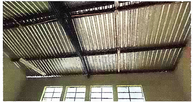
Foto 2: MODULO 1: SUSTITUCION DE LÁMPARAS
