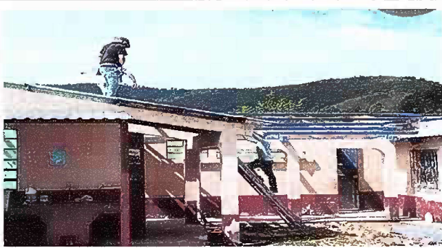
Foto1: MODULO 1: SUSTITUCION DE LÁMINA
