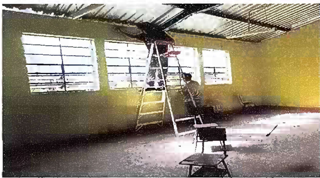
Foto 3: MODULO 1: REPARACION DE CABLEADO ELECTRICO
