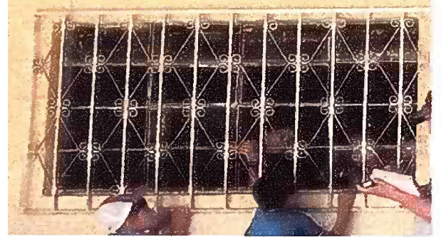
Foto 10: MODULO 2: MANTENIMIENTO DE BALCONES
