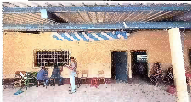
Foto 6: MODULO 2: PINTURA EN MUROS EXTERIORES E INTERIORES
