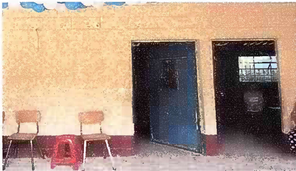
Foto 9: MODULO 2: MANTENIMIENTO A PUERTAS
