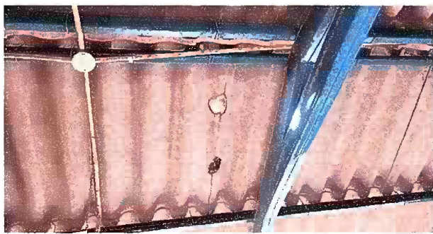
Foto 3: MODULO 1: REPARACION DE CABLEADO ELECTRICO
