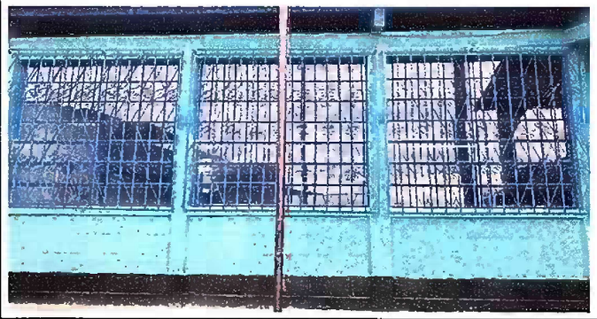
Foto 8: Módulo 3: Construcción de balcones de metal
