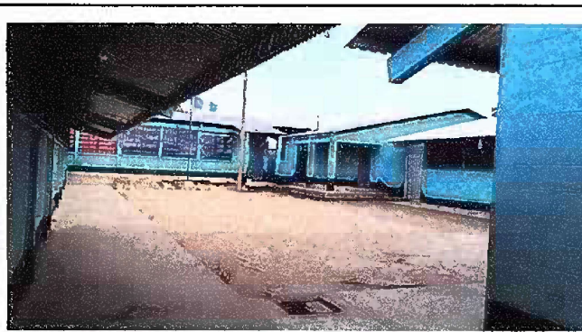
Foto 4: Pintura en paredes exteriores e interiores
