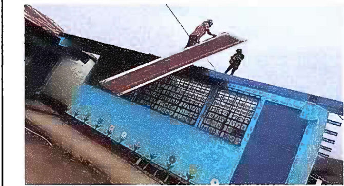
Foto1: Módulo 1: Sustitución de Lámina
