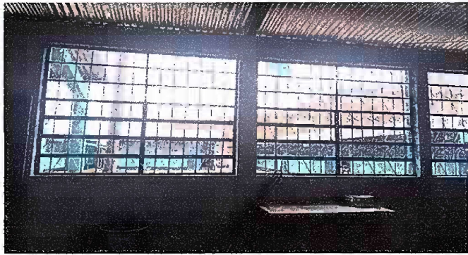
Foto7: Modulo 3: Sustitución de vidrios
