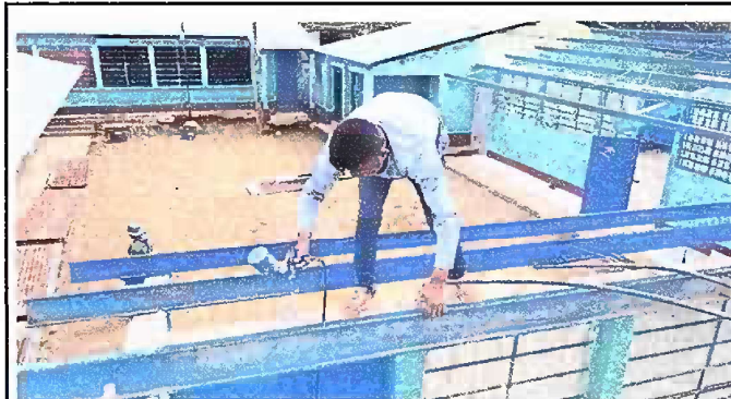
Foto 3: Módulo 2: sustitución de Lámina
