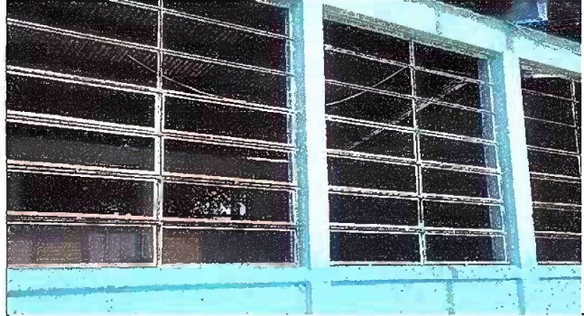
Foto 8: Módulo 3: Construcción de balcones de metal
