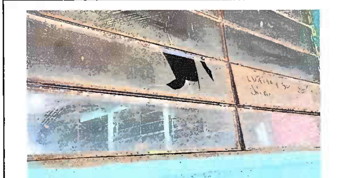
Foto 2: Módulo 1: Sustitución de vidrios
