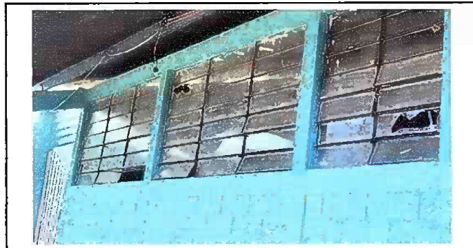
Foto 5: Módulo 2: Sustitución de vidrios
