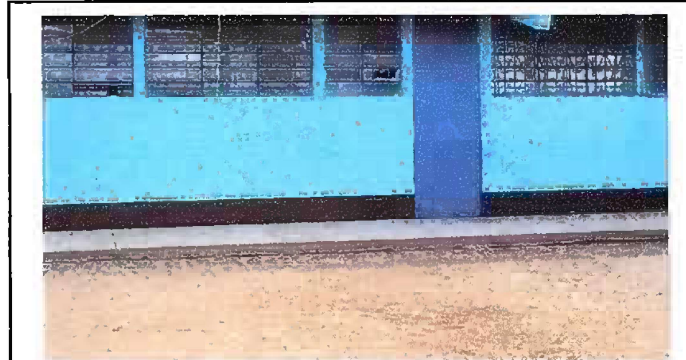
Foto 4: Pintura en paredes exteriores e interiores
