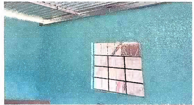
Foto 8: MODULO 2: SUSTITUCIÓN DE VIDRIOS
