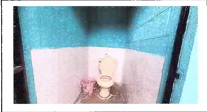
Foto 13: MODULO 3: SUTITUCION DE INODOROS
