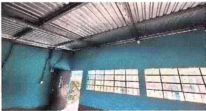
Foto 3: MODULO 1: CAMBIO DE LAMPARAS Y REPARACION DE CABLEADO ELECTRICO
