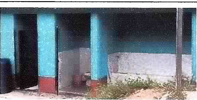
Foto 12: MODULO 2: PINTURA EN MUROS EXTERIORES E INTERIORES
