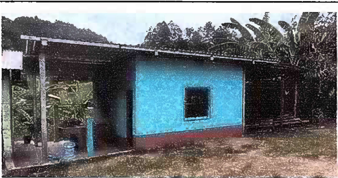
Foto 10: MODULO 2: PINTURA EN MUROS EXTERIORES E INTERIORES
