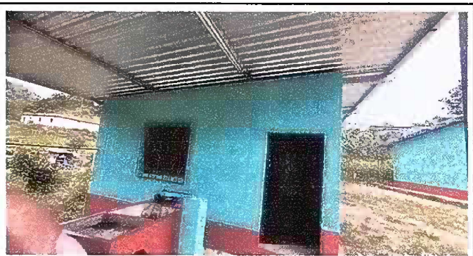
Foto 6: MODULO 2: SUSTITUCION DE LÁMINA
