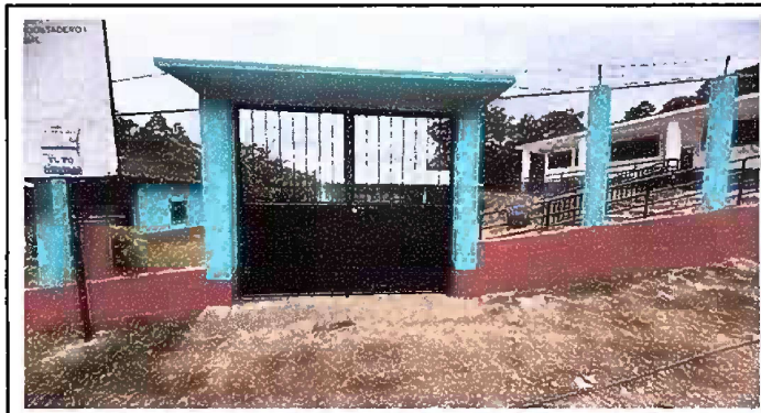
Foto 15: MANTENIMIENTO A PORTONES DE METAL
