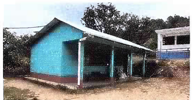
Foto 4: MODULO 1: PINTURA EN MUROS EXTERIORES E INTERIORES
