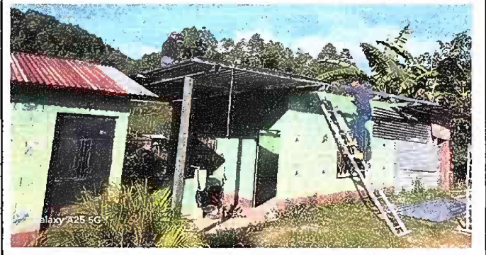
Foto 6: MODULO 2: SUSTITUCION DE LÁMINA
