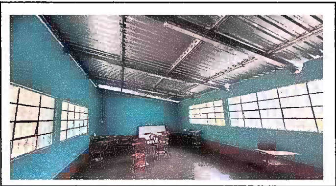
Foto 4: MODULO 1: PINTURA EN MUROS EXTERIORES E INTERIORES
