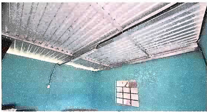
Foto 9: MODULO 2: CAMBIO DE LAMPARAS Y REPARACION DE CABLEADO ELECTRICO
