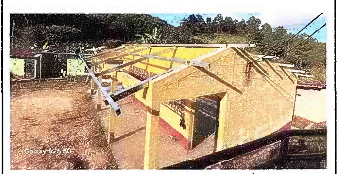
Foto1: MODULO 1: SUSTITUCIÓN DE LÁMINA
