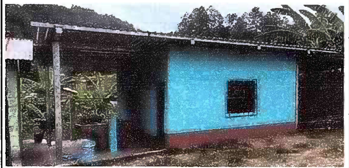
Foto 10: MODULO 2: PINTURA EN MUROS EXTERIORES E INTERIORES
