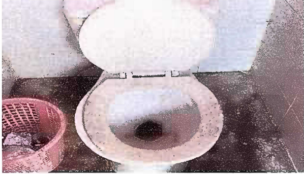
Foto 13: MODULO 3:SUTITUCION DE INODOROS
