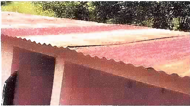
Foto 11: MODULO 3: SUSTITUCION DE LÁMINA
