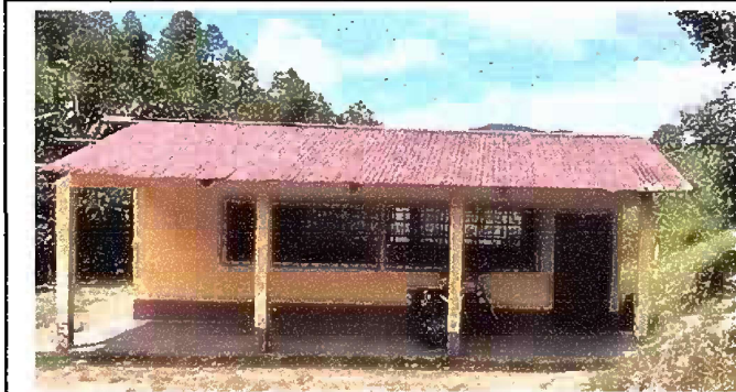
Foto1: MODULO 1: SUSTITUCIÓN DE LÁMINA
