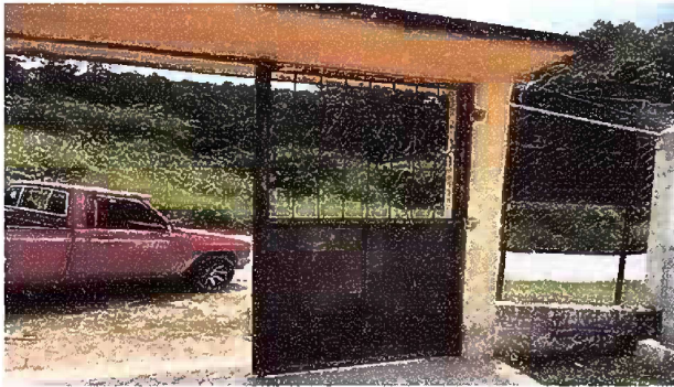
Foto 15: MANTENIMIENTO A PORTONES DE METAL
