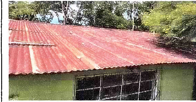
Foto1: MODULO 1: SUSTITUCIÓN DE LAMINA
