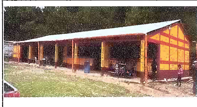
Foto 5: Pintura exterior en modulo 1, cocina y galera
