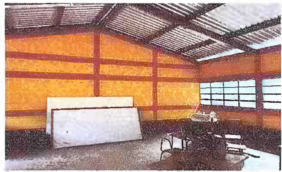
Foto 2: Modulo 1: Mantenimiento y Sustitucion de toda la red electrica de todo el modulo.
