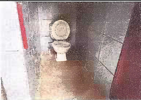
INSTALACION DE AZULEJO EN BAÑOS
