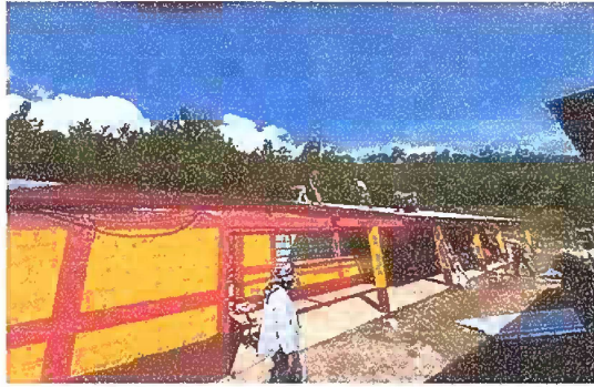
Foto1: Modulo 1: Mantenimiento de estructura de metal del techo y sustitucion de lamina en mal estado.
