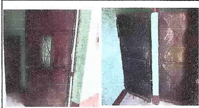
Foto 4: Mantenimiento de lijado, pintado y cambio de Chapas de todas las puertas del modulo 1
