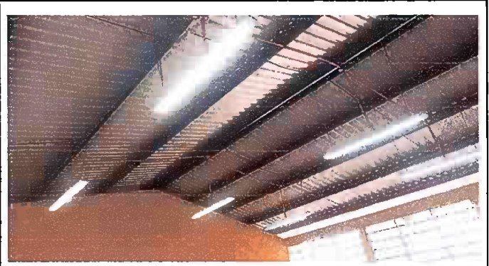
Foto 2: MODULO 1: SUSTITUCIÓN DE LAMPARAS
