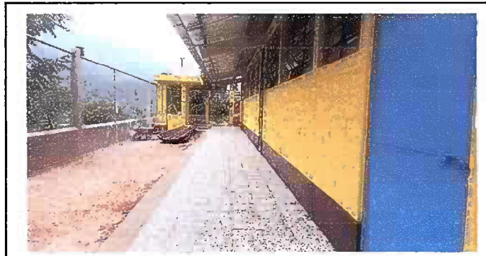
Foto 5: MODULO 1: REPARACION DE PLANCHA DE CONCRETO
