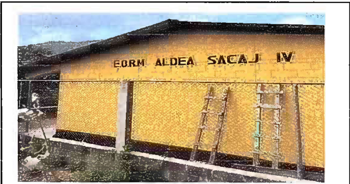
Foto 6: MODULO 1: PINTURA GENERAL EN MUROS EXTERIORES E INTERIORES
