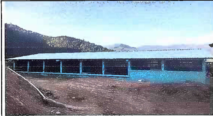
Foto1: MODULO 1: SUSTITUCIÓN DE LÁMINA
