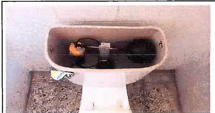
Foto 3: MODULO 1: SUSTITUCION DE ACCSESORIOS DE SANITARIOS
