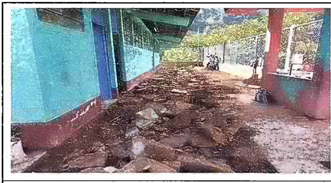
Foto 5: MODULO 1: REPARACION DE PLANCHA DE CONCRETO
