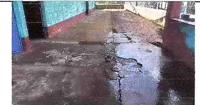
Foto 5: MODULO 1: REPARACION DE PLANCHA DE CONCRETO
