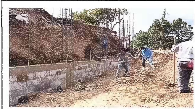
Foto 4: REPARACION DE MURO DE CONTENCIÓN
