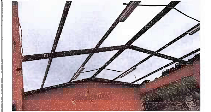
Foto 1: MODULO 1: SUSTITUCION DE LÁMINA
